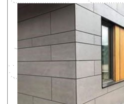
E2C STONE VENEER CLADDING
