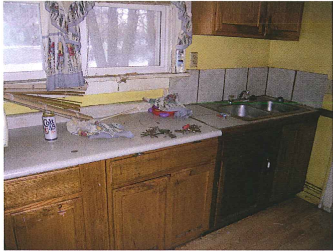
2037 S. PARK STREET
