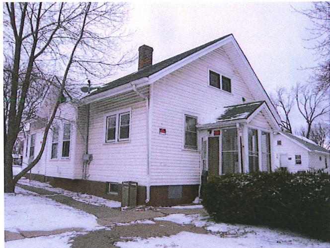
2037 S. PARK STREET
