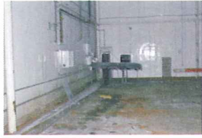
1010 S. Park Interior 26.jpg
