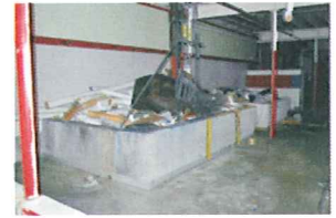
1010 S. Park Interior 13.jpg
