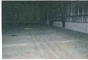
1010 S. Park Interior 6.jpg
