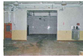
1010 S. Park Interior 17.jpg
