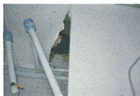
1010 S. Park Interior 19.jpg
