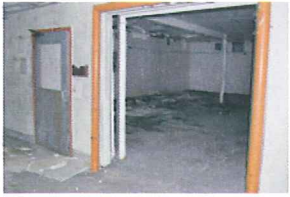
1010 S. Park Interior 24.jpg
