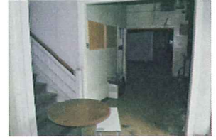
1010 S. Park Interior 3.jpg
