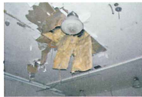
1010 S. Park Interior 16.jpg
