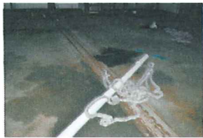
1010 S. Park Interior 9.jpg
