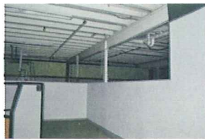
1010 S. Park Interior 14.jpg
