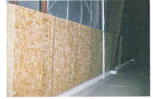
1010 S. Park Interior 8.jpg
