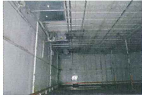
1010 S. Park Interior 1.jpg
