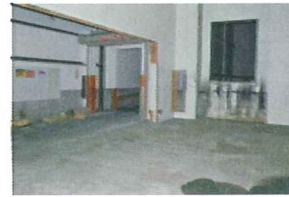
1010 S. Park Interior 12.jpg
