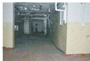
1010 S. Park Interior 20.jpg
