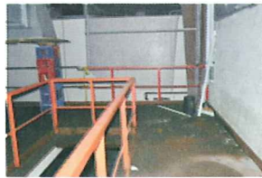
1010 S. Park Interior 10.jpg
