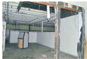
1010 S. Park Interior 15.jpg
