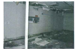
1010 S. Park Interior 23.jpg
