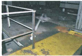
1010 S. Park Interior 11.jpg
