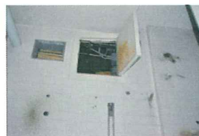
1010 S. Park Interior 21.jpg
