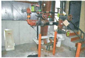
1010 S. Park Interior 4.jpg
