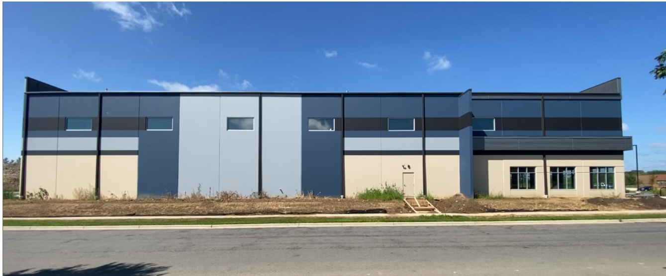
Existing - 4725 Tradewinds Pkwy
