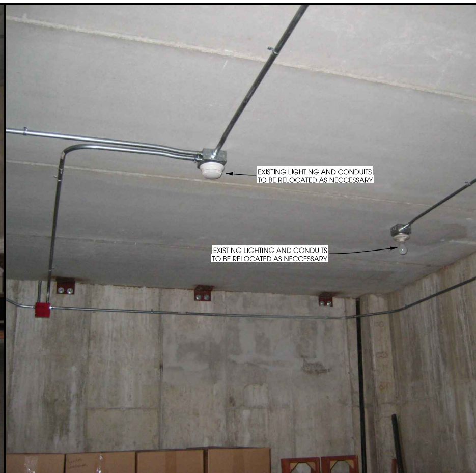
EXISTING CONDUITS ON CEILING
