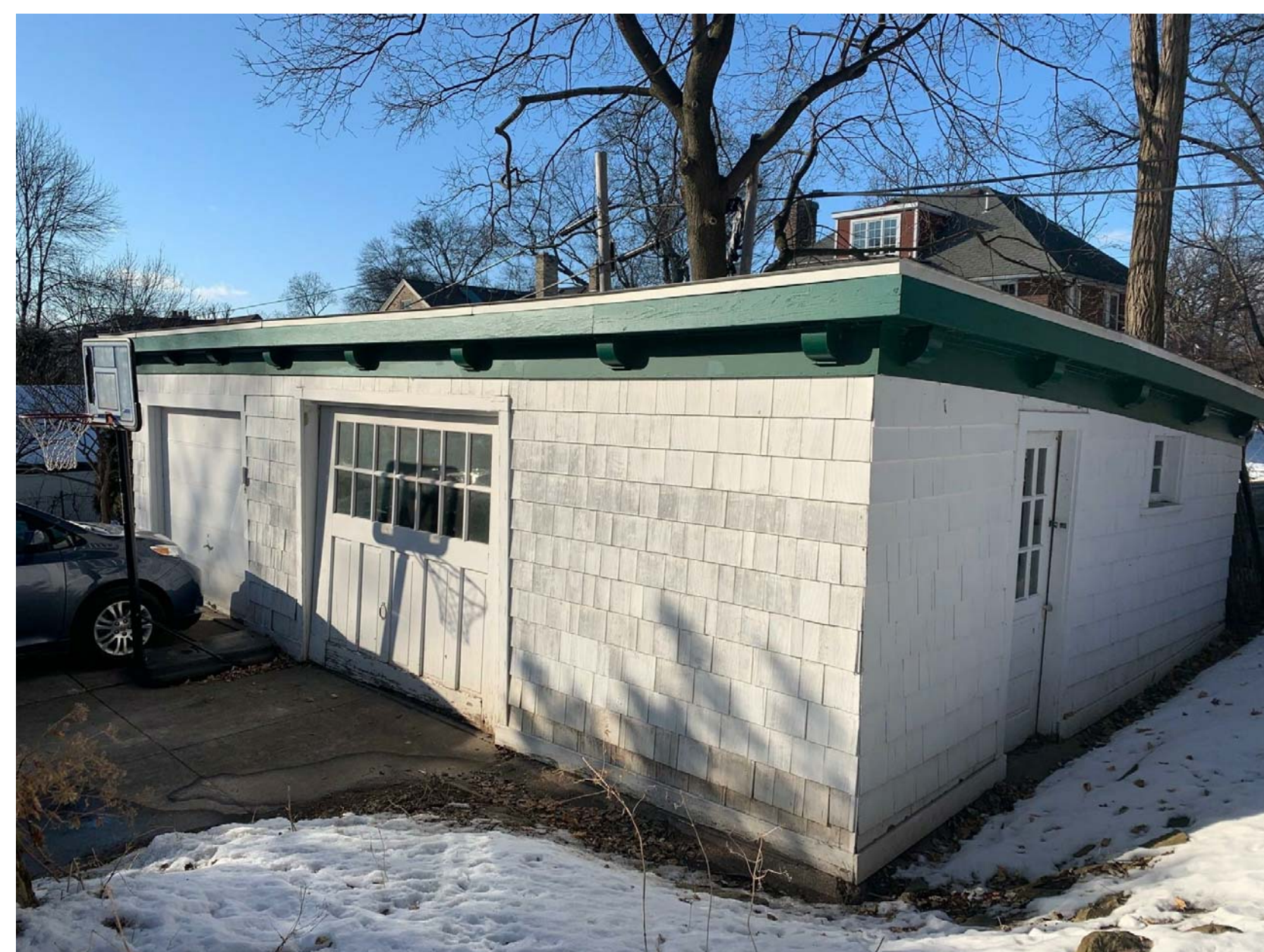
GARAGE SE CORNER
