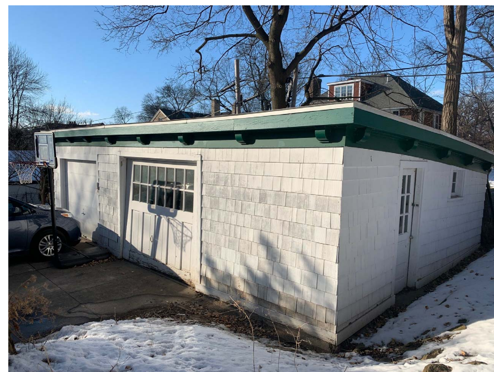
GARAGE SE CORNER
