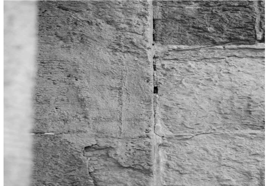
Spalling
