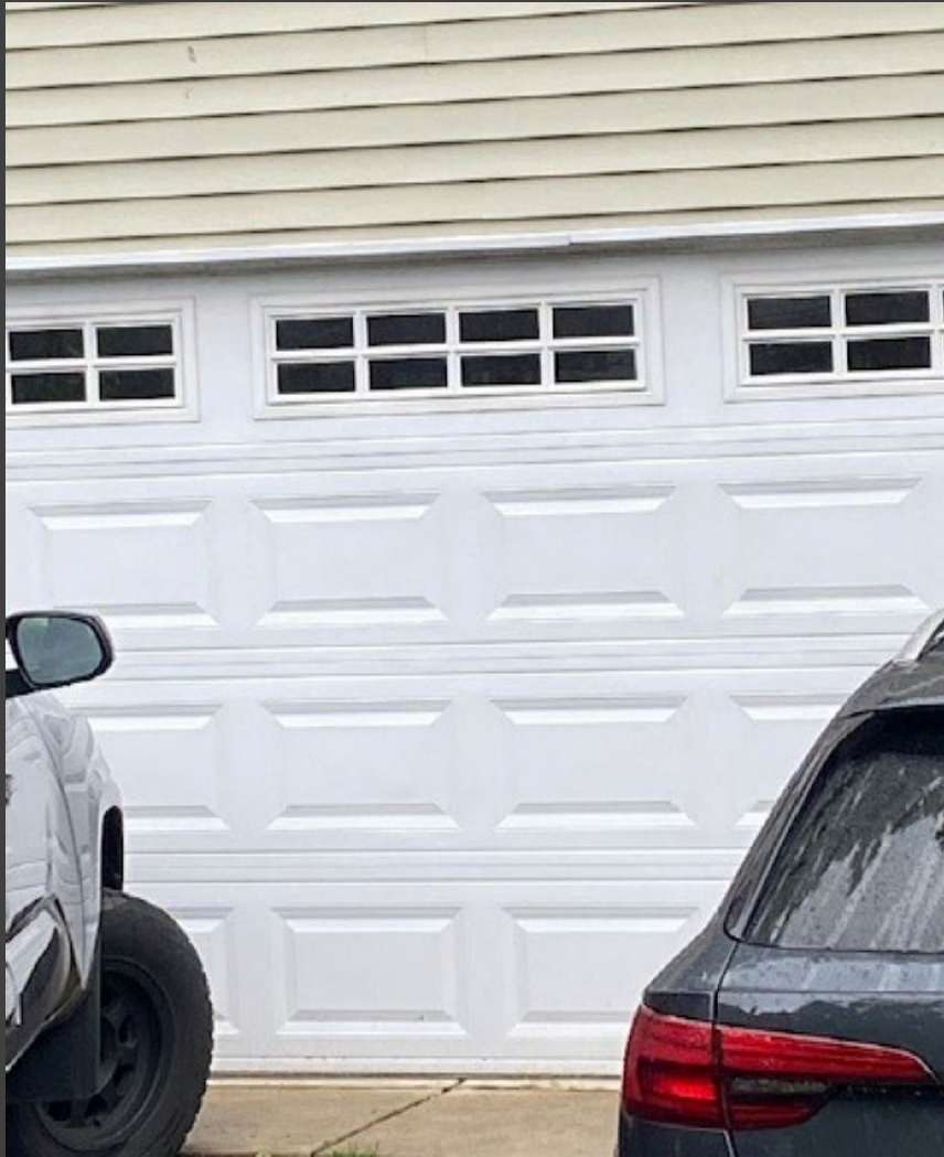
1323 Spaight garage door
