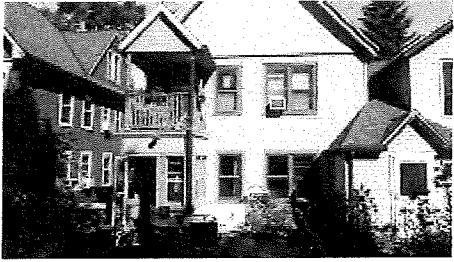
Exiting back porch#5.jpg 4483K
