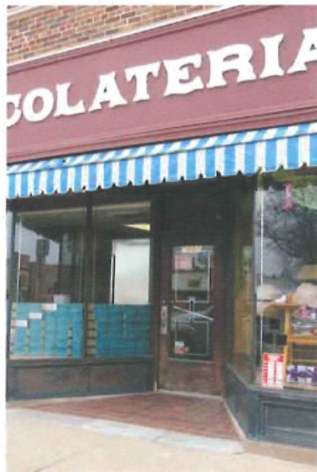
ADJACENT TENANT SPACE ORIGINAL 1923 STOREFRONT
