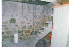
918 Midland Basement 2.jpg
