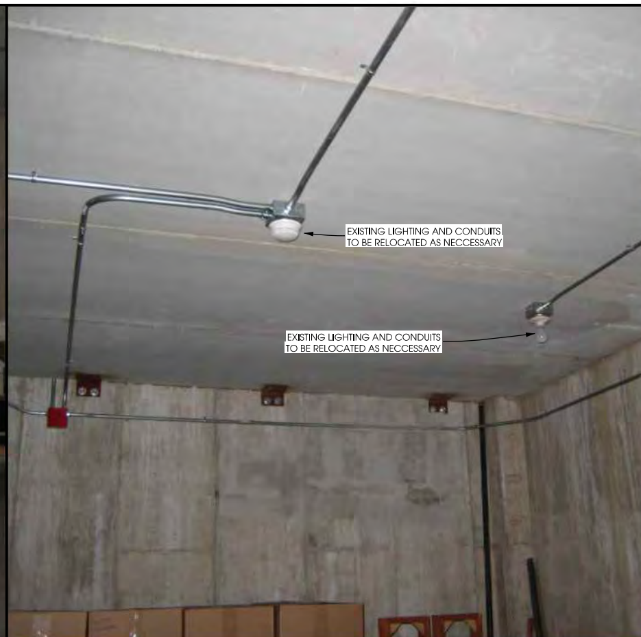
EXISTING CONDUITS ON CEILING
