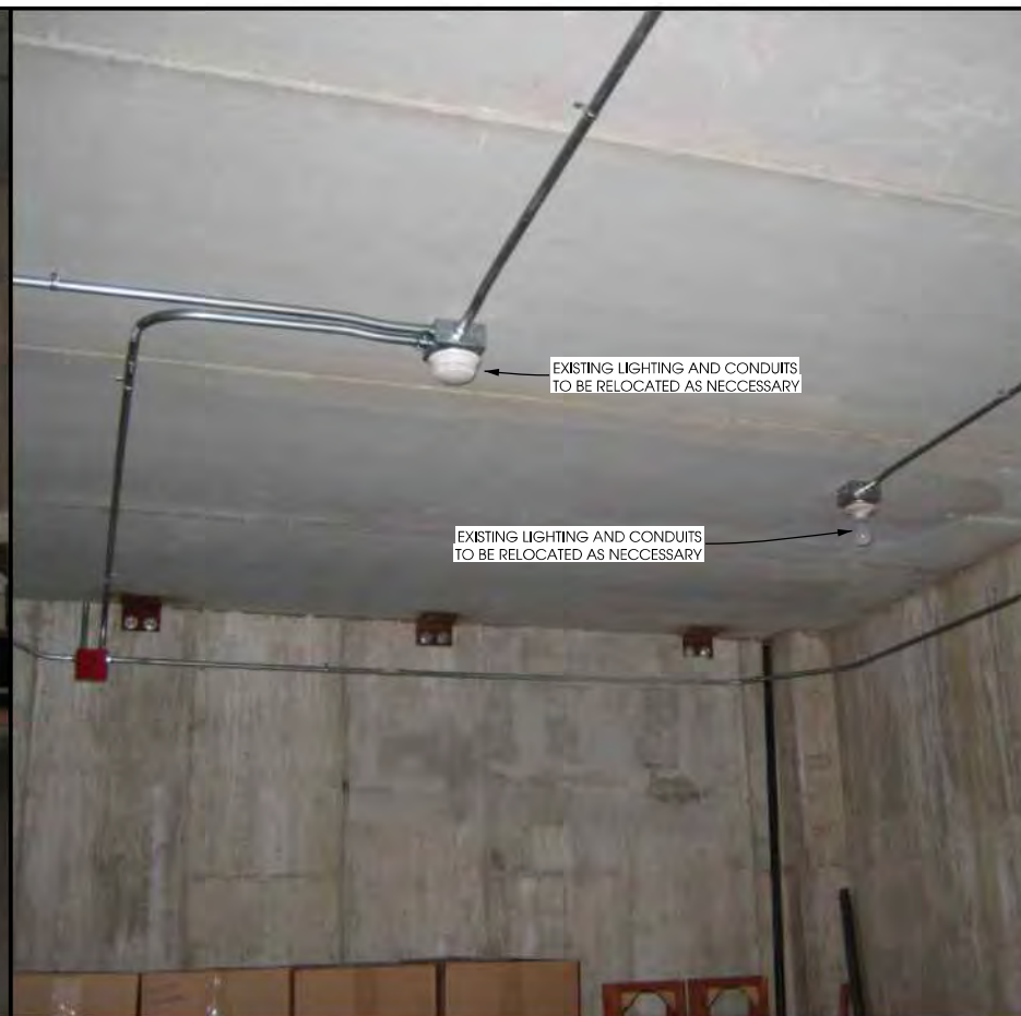
EXISTING CONDUITS ON CEILING
