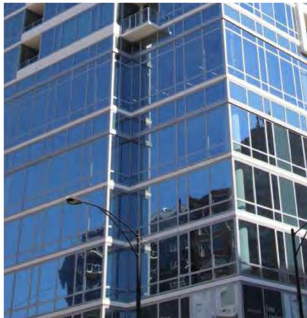
EWS-1 ALUMINUM AND GLASS WINDOW WALL /SLAB EDGE COVER SYSTEM (SIM)
